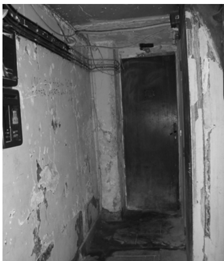
Imagen 3. Escalera interior en edificio de vivienda.
