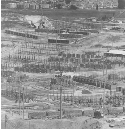
Imagen 4. Construcción de viviendas en Ciudad Bolívar. Fuente: Caja de la Vivienda Popular. Los Más Pobres... Los Primeros .
