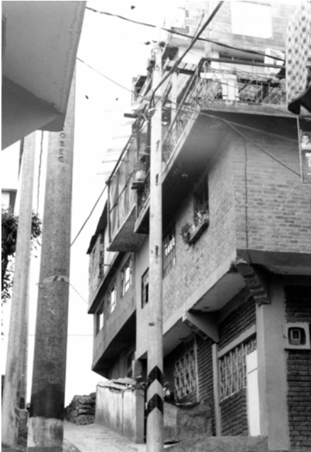
Imagen 10. Barrio Las Guacamayas. Estado actual de las viviendas. Fuente: Barrio Taller.
