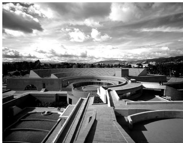
Imagen 11. Constatación en la cubierta de la existencia de modelos diferenciados. El paso de la cubierta de un modelo a otro debe realizarse por medio de escaleras o puentes.
